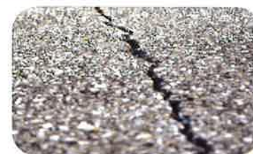
Fissure longitudinale
